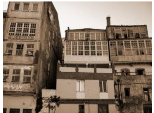
Galerías del Puerto de Finisterre.
